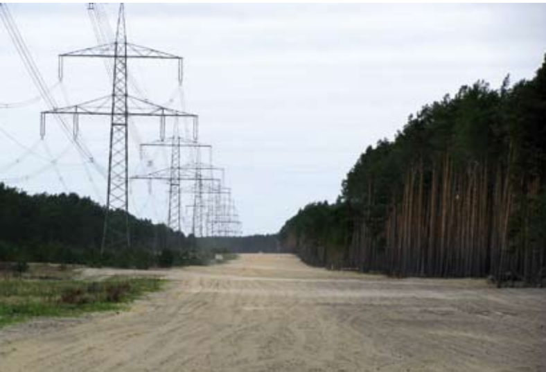
Trassenbündelung der OPAL mit anderen Energieleitungen
