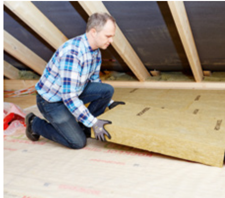
Dämmen der obersten Geschossdecke
